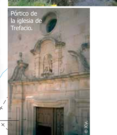
Pórtico de la iglesia de Trefacio.
