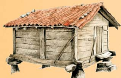
Los hórreos de Besande responden al estilo leonés: pequeño tamaño, forma rectangular, paredes de tablas horizontales y techo a dos aguas, pero sorprende por la escasa altura de sus pilastras.
