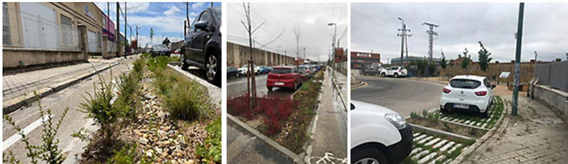
MEDIDAS DE ADAPTACIÓN - Ejemplo de implementación de SbN en las áreas industriales de las ciudades: drenaje urbano sostenible en el Polígono Industrial de Valladolid. Fuente: Proyecto INDNATUR
