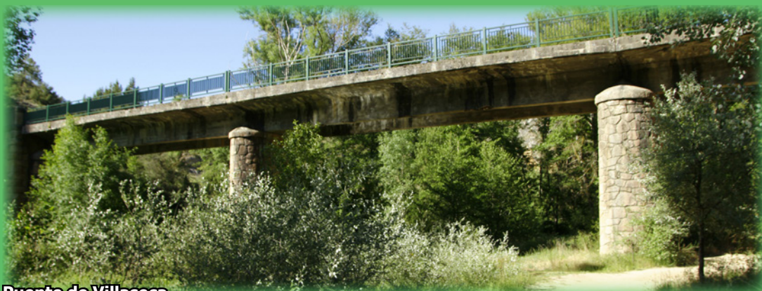
Puente de Villaseca
