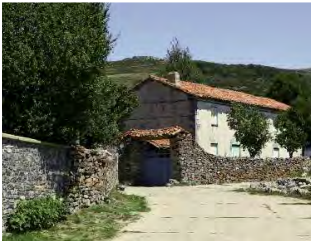
Al lado de construcciones reformadas, algunas casas de La Lastra conservan viejos muros de piedra contruidos sin argamasa delimitando corrales que se abren a la calle por medio de grandes portales.
