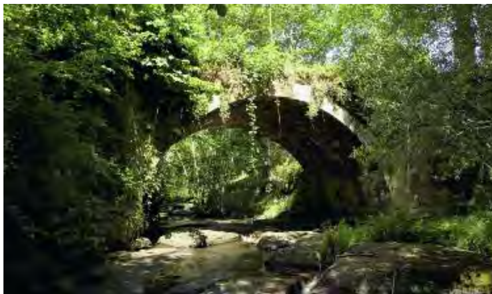
El puente de Rojadillo formaba parte de una vía romana de segundo orden, aunque su fábrica actual corresponde más bien a época medieval.
