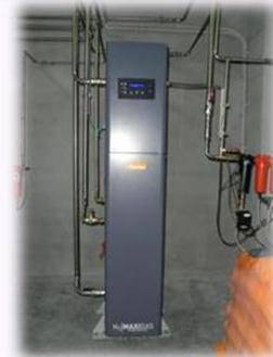
Figura 15. Equipo de generación de nitrógeno estándar
