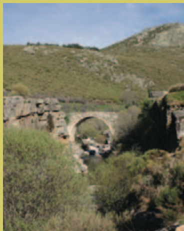
Pozo de las Paredes en Navacepeda de Tormes
