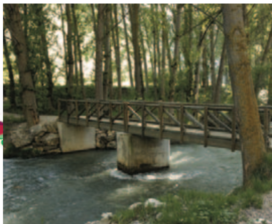
Puente peatonal sobre el río
